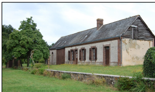
↑ Les Écoles - ferme de type « bloc-à-terre » simple
